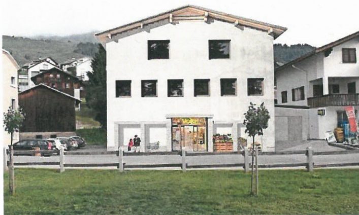
Noch vor Weihnachten bezugsbereit: Der Caminada-Bau fügt sich gut in das bestehende Ortsbild von Vella ein.
