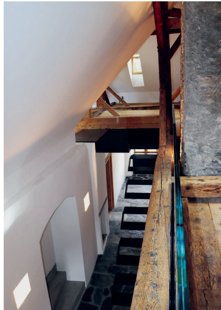
Die moderne Stahltreppe fügt sich leicht in die alte Bausubstanz ein.
