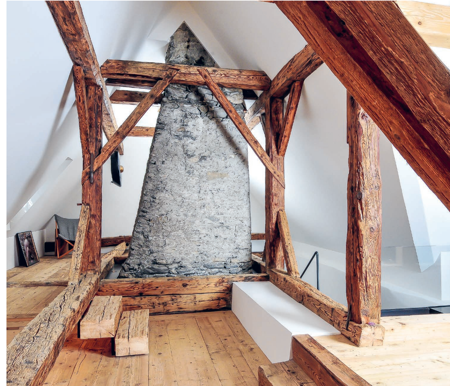
Das Dachgeschoss ist zu einem lichten Atelier umgebaut worden.
